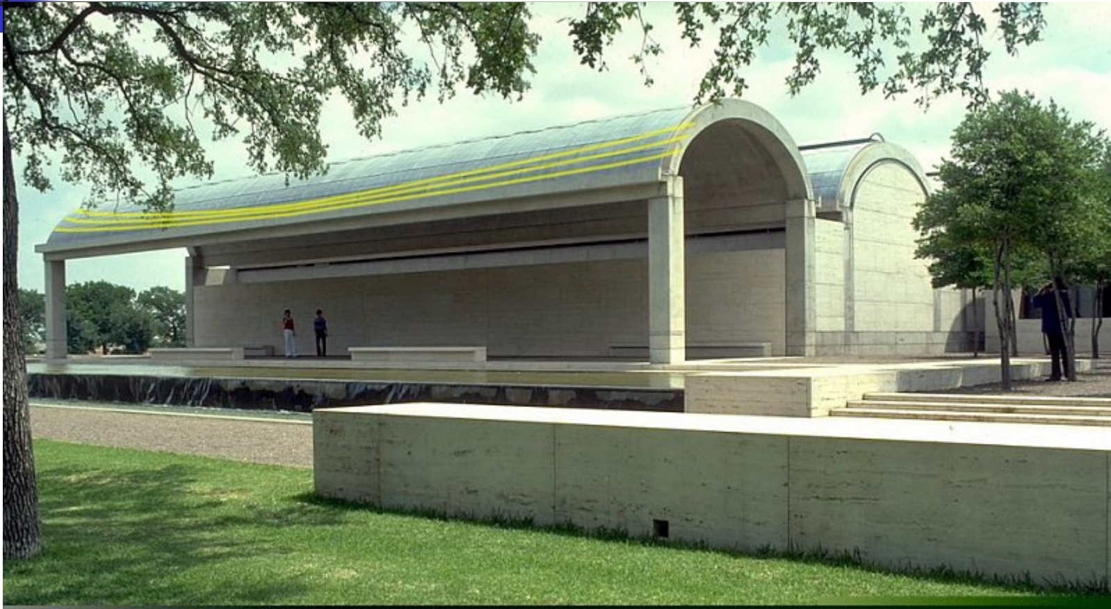
Cobertura em casca cilíndrica
