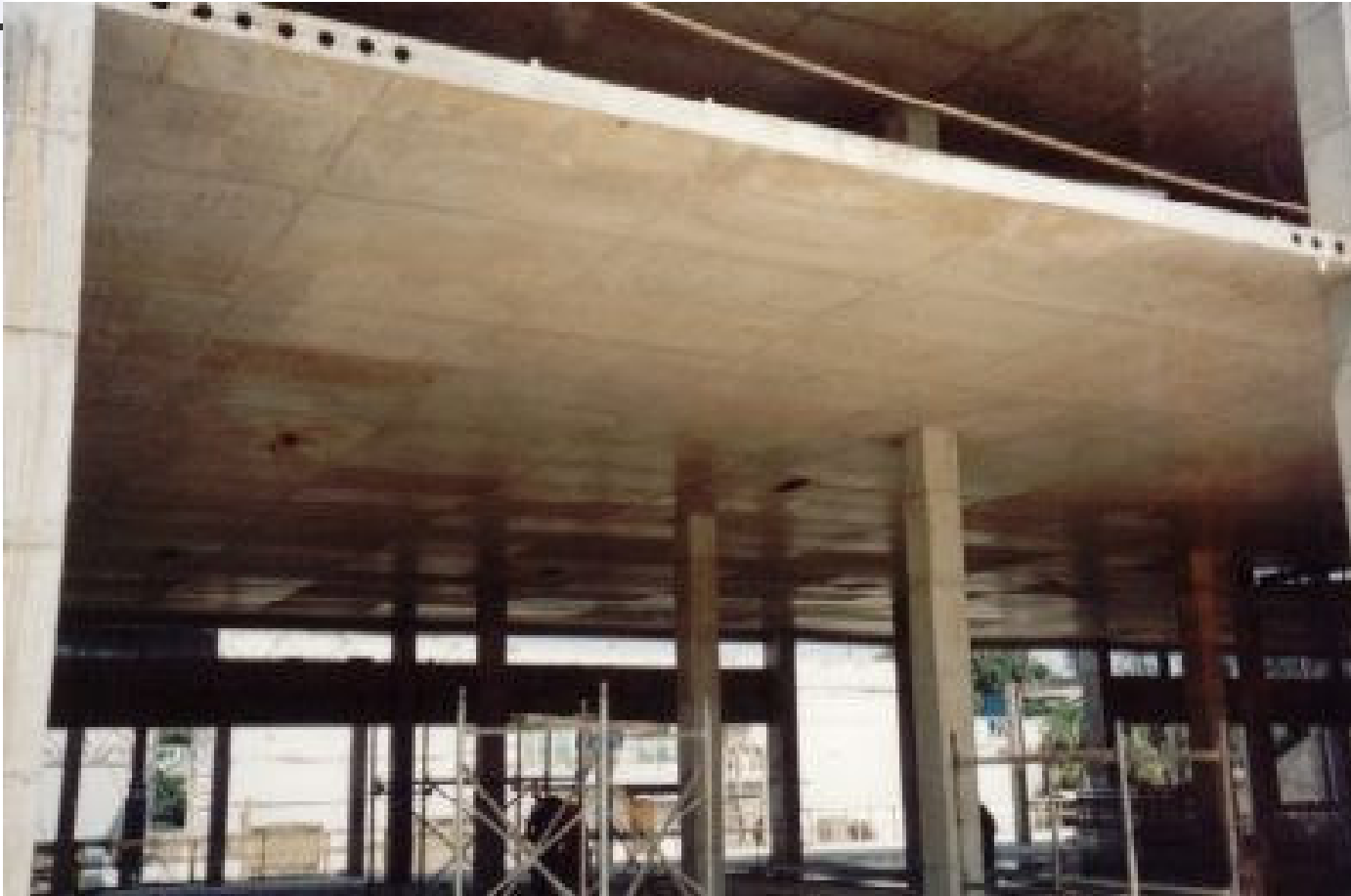
Protensão de lajes
