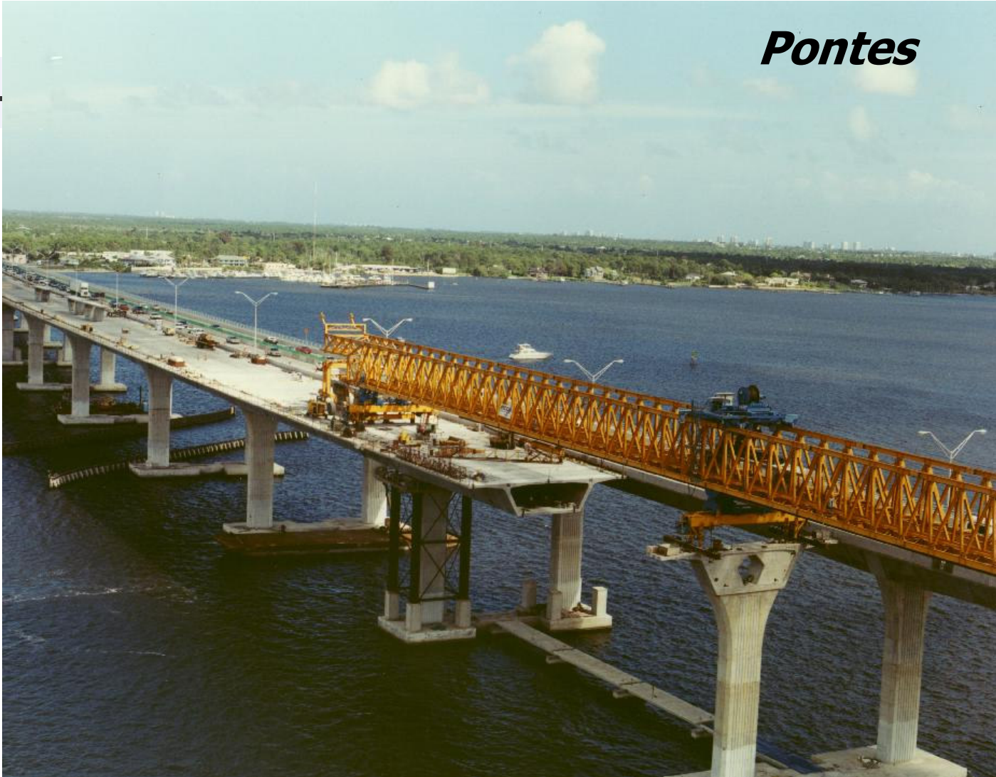
Balanço sucessivo com aduelas pré-moldadas
