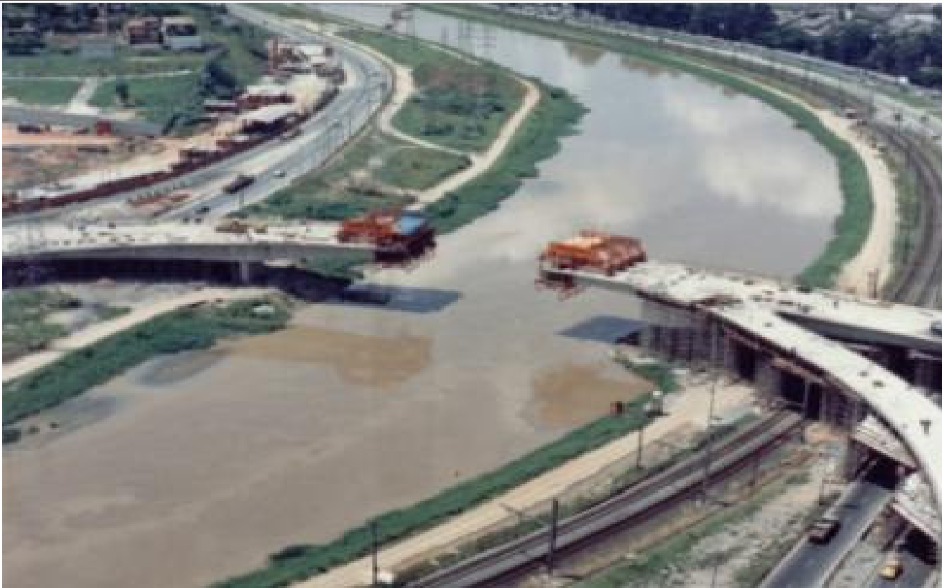
Balanço sucessivo com aduelas pré-moldadas
