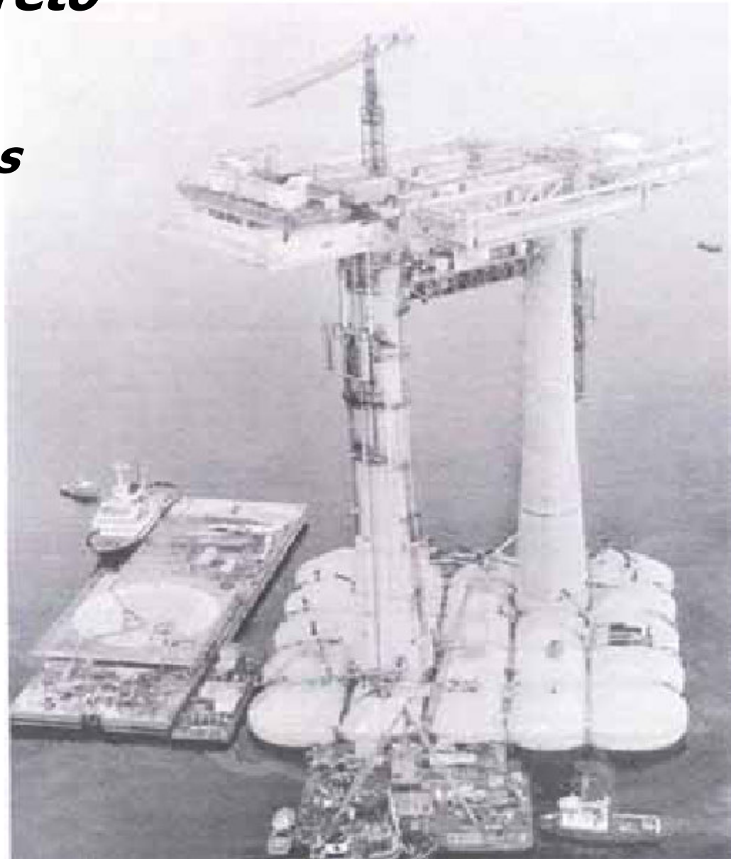
Plataforma de petróleo em construção
