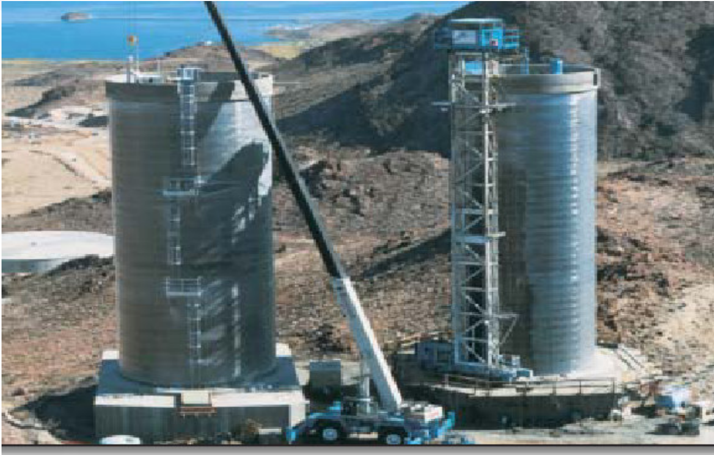
Construção de silos verticais (protensão circular)
